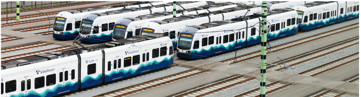
Damos servicio a nuestros trenes ligeros actuales en una OMF central en South Forest Street en Seattle.
